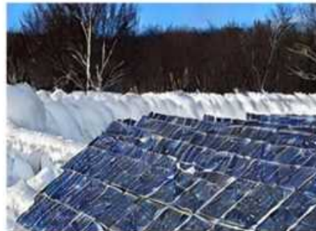
氷雪による太陽光発電設備の破損イメージ ※実際の事故画像ではありません。
