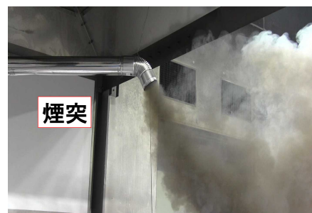
石油給湯機が異常燃焼して、煙突から煙が出ている様子
