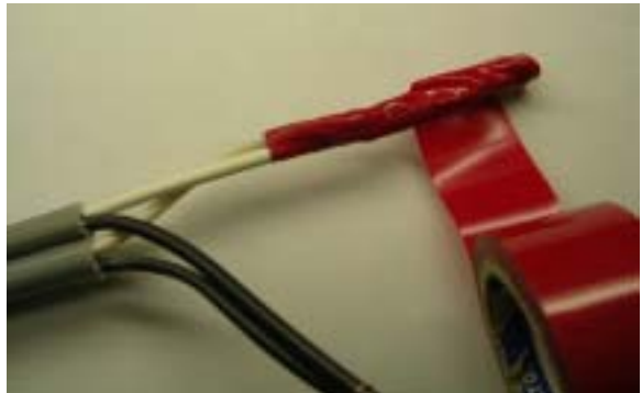
g . 終端で折り返し巻き始めまで巻付ける。
