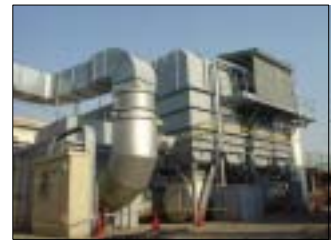
VOC排ガス燃焼装置
