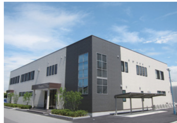
照明にLEDを使用した省エネルギータイプの厚生棟
