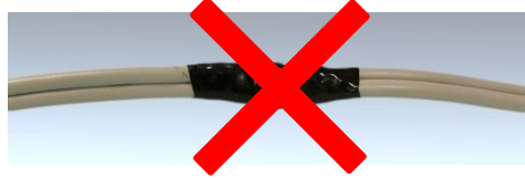
(写真) 断線部の補修
