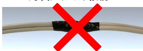
(写真) 断線部の補修
