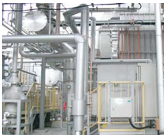
ジクロロメタンの吸着回収設備
