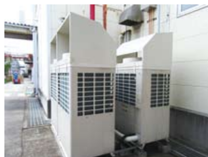
フード設置室外機
