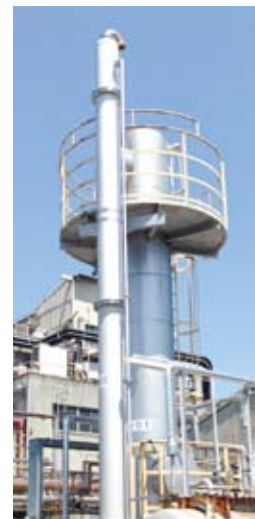
排ガス処理装置
