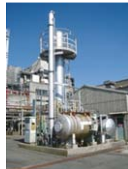
臭気物質吸収設備
