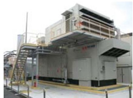
コジェネレーション発電システム
