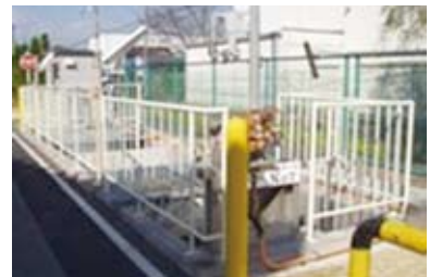
川田Ⅱ排水ピット
