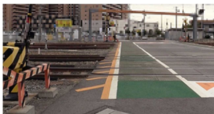
写真3 踏切の歩道の例
