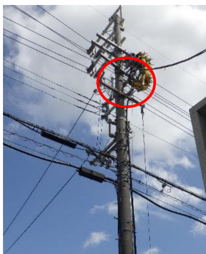
写真1 波及事故発生現場
