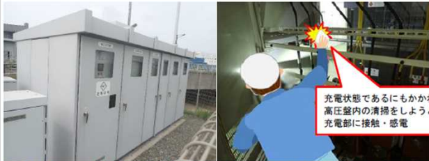
【図1】キュービクル(高圧受電設備) 【図2】受電室の感電死傷事故のイメージ※ ※実際の事故画像ではありません。
