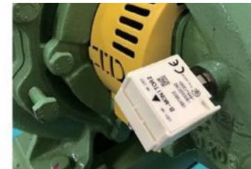
小型無線式センサの外観（左）とポンプにセンサを設置した状態（右）
