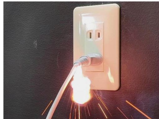
電源コードの半断線によるショート
