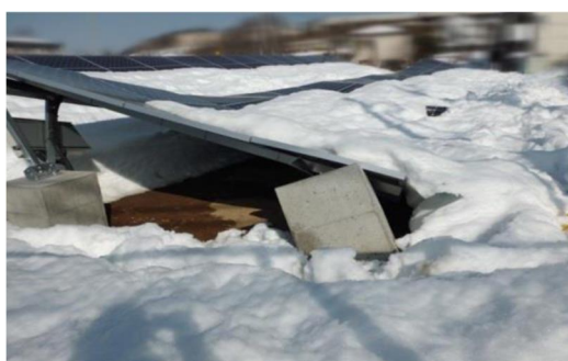
（図1）積雪による太陽電池発電所の破損
