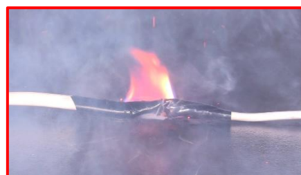
電源コードの修理箇所から発火する様子
