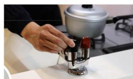
ガスの元栓を閉める様子
