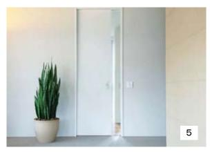
洗面室との間などの段差(敷居)をできるだけなくし、高齢者がつまずいて転倒しないように配慮していたり、引き戸を思いきり閉めた時でも、誤って指を挟んだりしないように指はさみ防止装置や手を離しても自動で閉まるクローサー付きのドア(写真5)なども装備しています。
